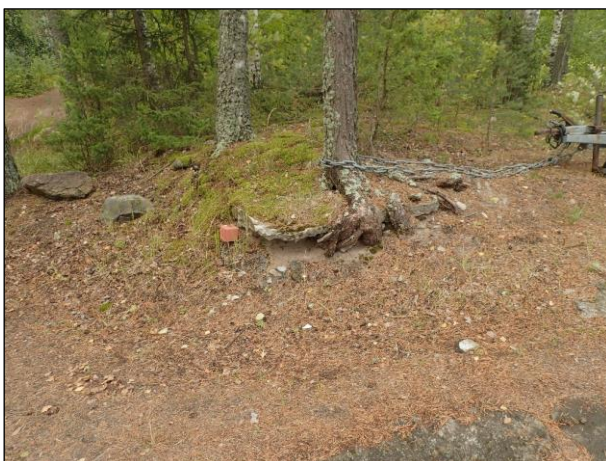
Pienen rakennuksen perustaa, jossa päällä betonista valettu lattia
